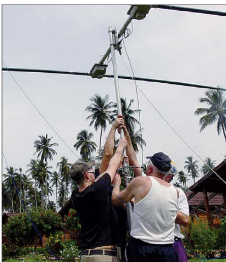
Antennenbau ist Teamarbeit: beim Errichten der 2-Element-Stepp-IR
