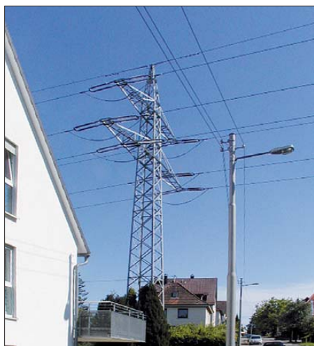
110-kV-Trasse durch Wohnsiedlung; machen die 50-Hz-Magnetfelder krank? Foto: DL5KAZ
